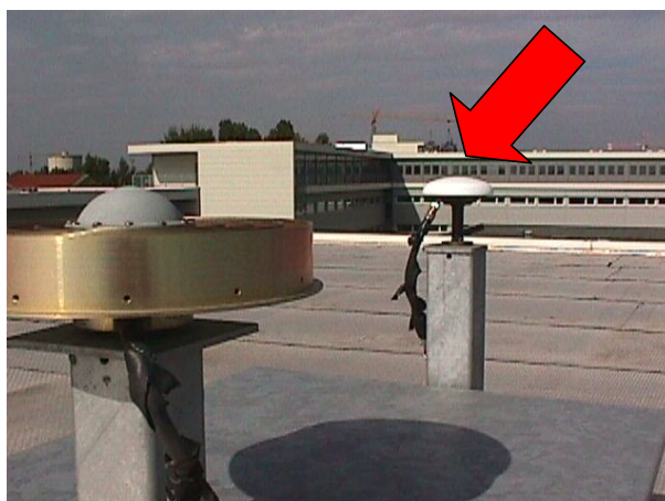
Figura 4. Monumentazione della stazione GPS di Ferrara. In evidenza l'antenna del ricevitore StarFire.
